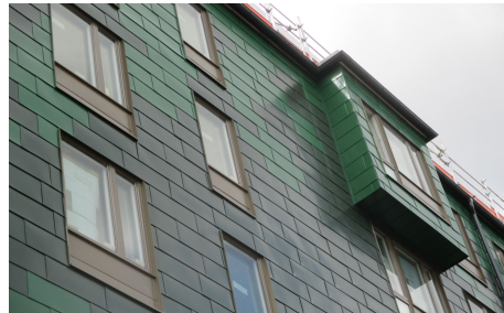
Figure 14. Green metal facade (Roslagens plåtkonsult, n.d.).
