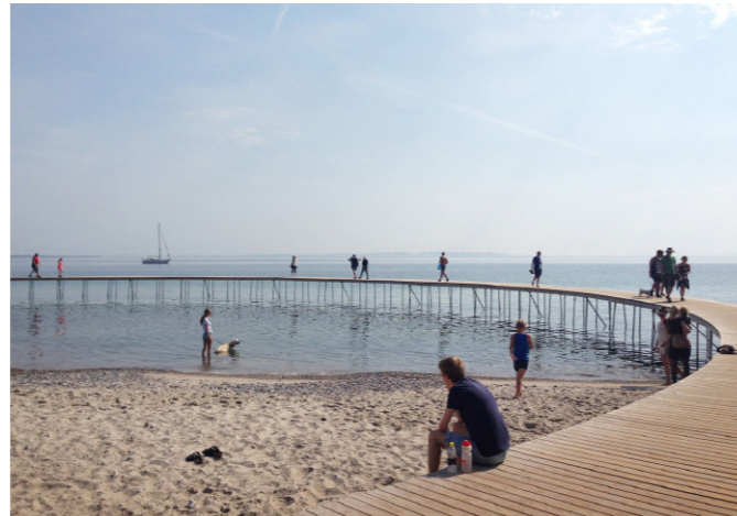
Visitors view of bridge (Gjøde & Povlsgaard Arkitekter)
