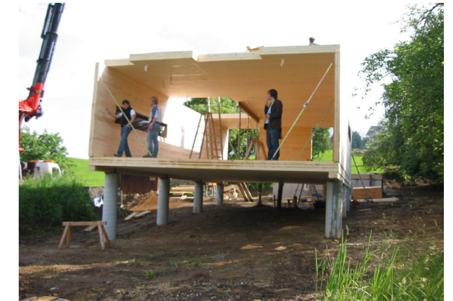
Figure 12. Plattbjälklag av KL-trä (Träguiden 2020)
