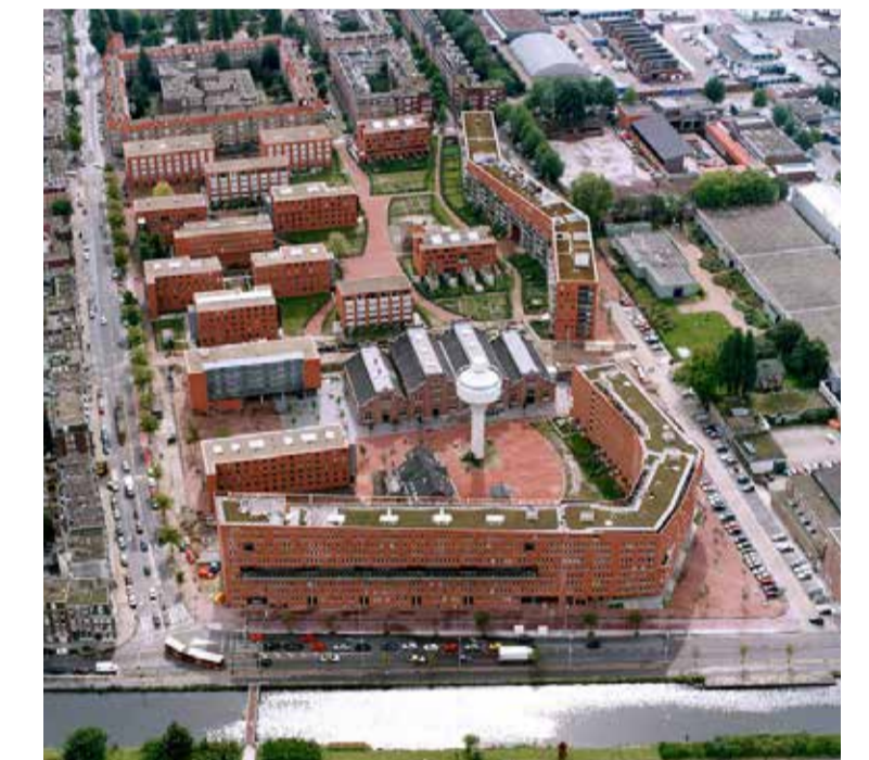
De privata gårdarna till lamellhusen är inspirerade av GWL terrain i Amsterdam där de arbetat med häckar i spännande former för att skapa rum.
