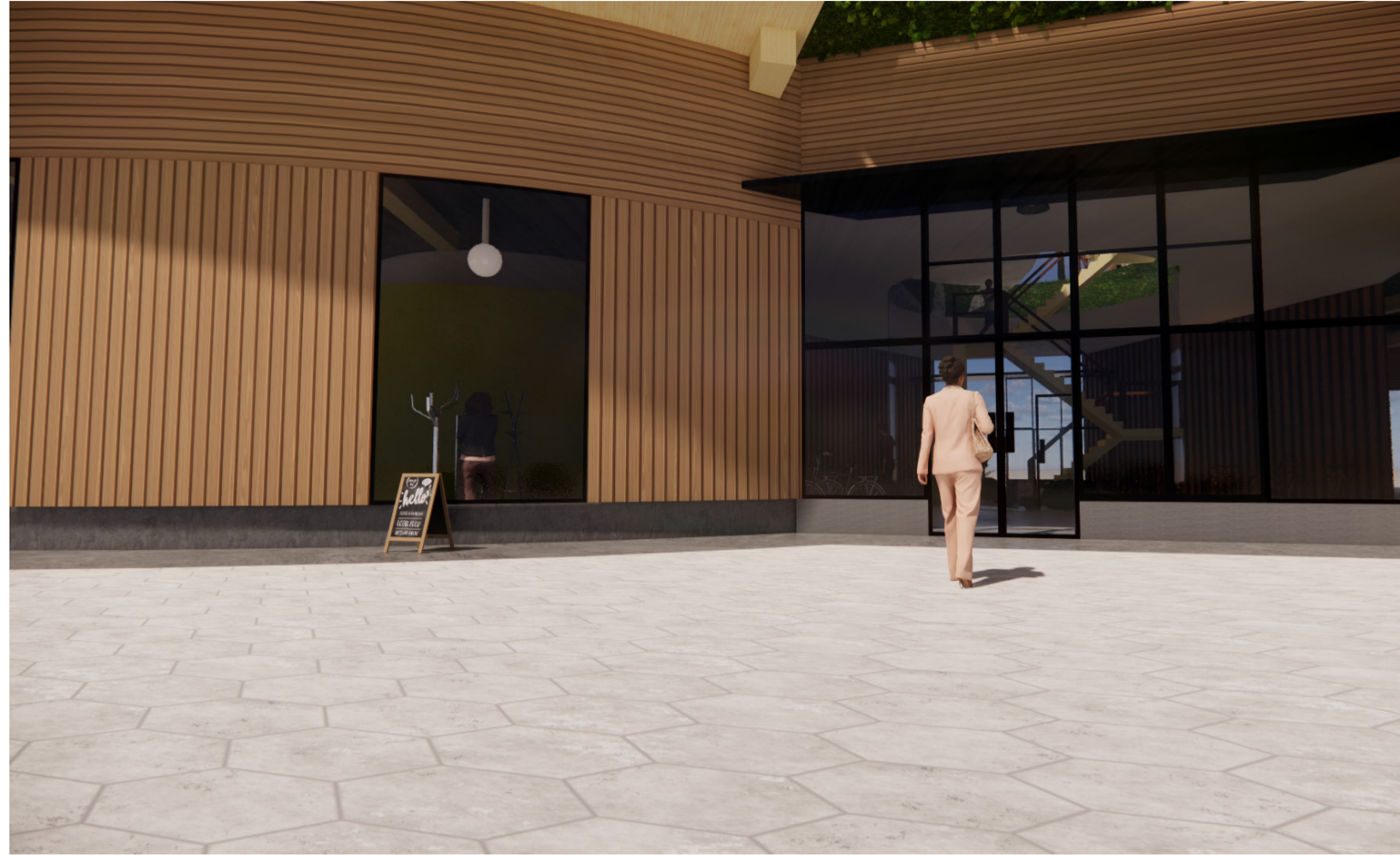
Bottenvåningens exteriör. I bottenplan ges det möjlighet för verksamheter av olika slag. De större entréerna är tydligt utmarkerade genom övertak och helt glasade fasader.
