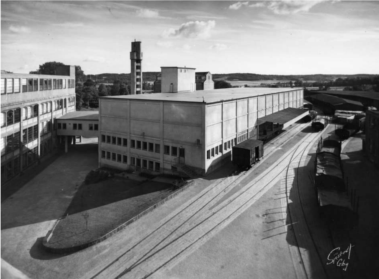
Fig. 10, Building 110. Föreningsarkivet i Västra Götaland (1948).
