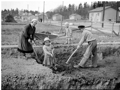
Figure 2.10 Excavation process (© Schaktning pågår i småstugeområde, 1935)
