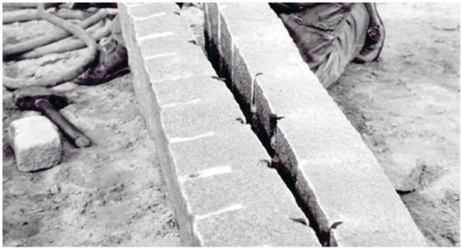
Figure 19. Rixö knottfabrik. (unknown photographer, 1938). Figure 20. Installation av H-såg. (unknown photographer, 1959). Figure 21. En man borrar i ett granitblock för att klyva det, i fickan har han en tumstock. (Evers, n.d). Figure 22. Kilar slås ner i ett stenblock för att klyva det. (Evers, n.d). Figure 23. Ett stenblock klyvs längs borrhålen genom att kilar slås ner i borrhålen. (Evers, n.d).
