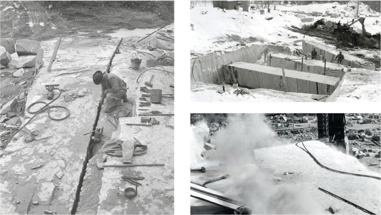
Figure 16. Rixö Stenbrott 1966. (Fredh, 1966). Figure 17. Stenbrott. (Granströms foto, 1950-1959). Figure 18. Röken Stiger från en sprängladdning som lossat ett stenblock från berget. (Evers, nd).
