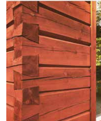
F3: Timmerhuset, dovetail joints. (FABEL arkitektur, n.d.).
