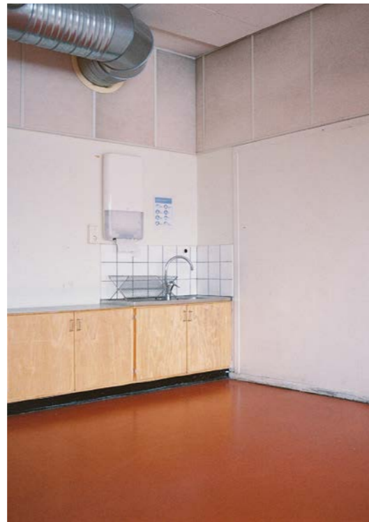
CLASSROOM SINK, A3 II
