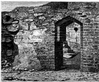
Fig. 54. Dörröppning mellan rummen nr 16 och 17. Efter fotografi.
