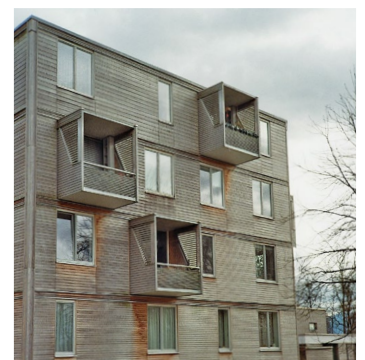
Schankula Architekten Holz 4 Bad Aibling, Germany.
