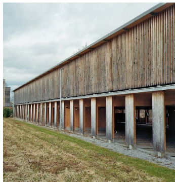
Hermann Kaufmann Holzparkdeck Bad Aibling, Germany.
