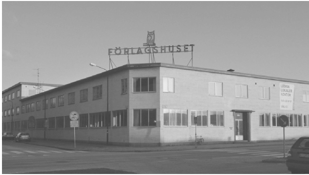
[Figure 35] - Förlagshuset Photo (Andersson, 2015)
